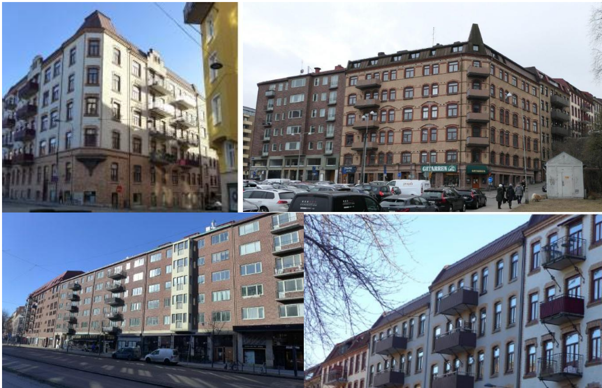
Befintlig bebyggelse. Fasad mot: Kastellgatan/Risåsgatan, Skanstorget/Kastellgatan, Övre Husargatan, Kastellgatan
