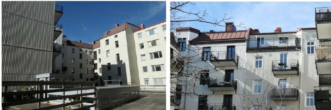
Figur 14. Till vänster: Gårdsfasad Skanstorget 10 uppförd 1898. fasaden är tilläggsisolerad och klädd med plåt. Foto Antiquum. Till höger: Gårdsfasad på Kastellgatan 6, uppförd 1930. Fasaderna är tilläggsisolerade, mot gården har det tillkommit en takterrass. Foto Antiquum
