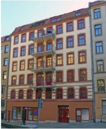
Figur 7. Fasad mot Kastellgatan. Foto Antiquum AB.
