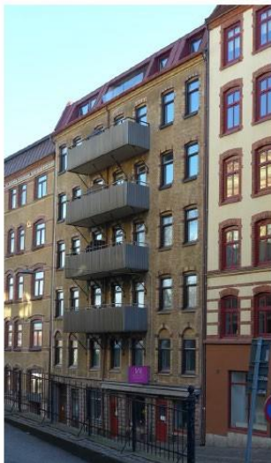
Figur 8. Fasad mot Kastellgatan. Foto Antiquum AB.
