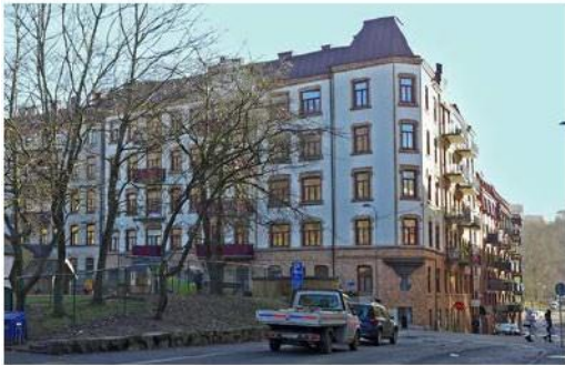
Figur 5. Fasad mot Kastellgatan. Foto Antiquum AB.
